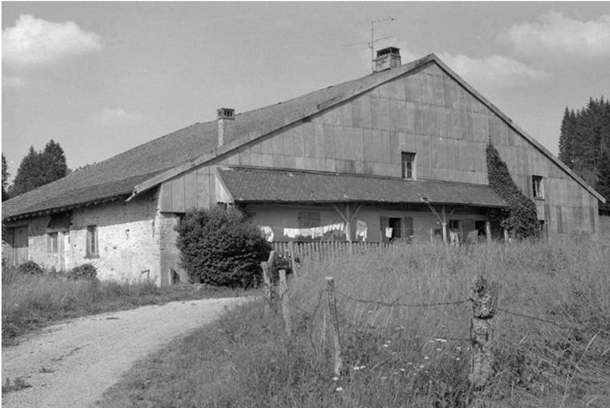
Façades antérieure et latérale gauche.
