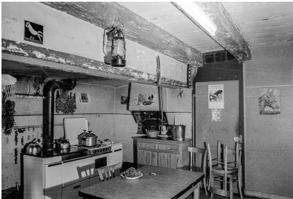
Cuisine : poutre supportant la cheminée.
