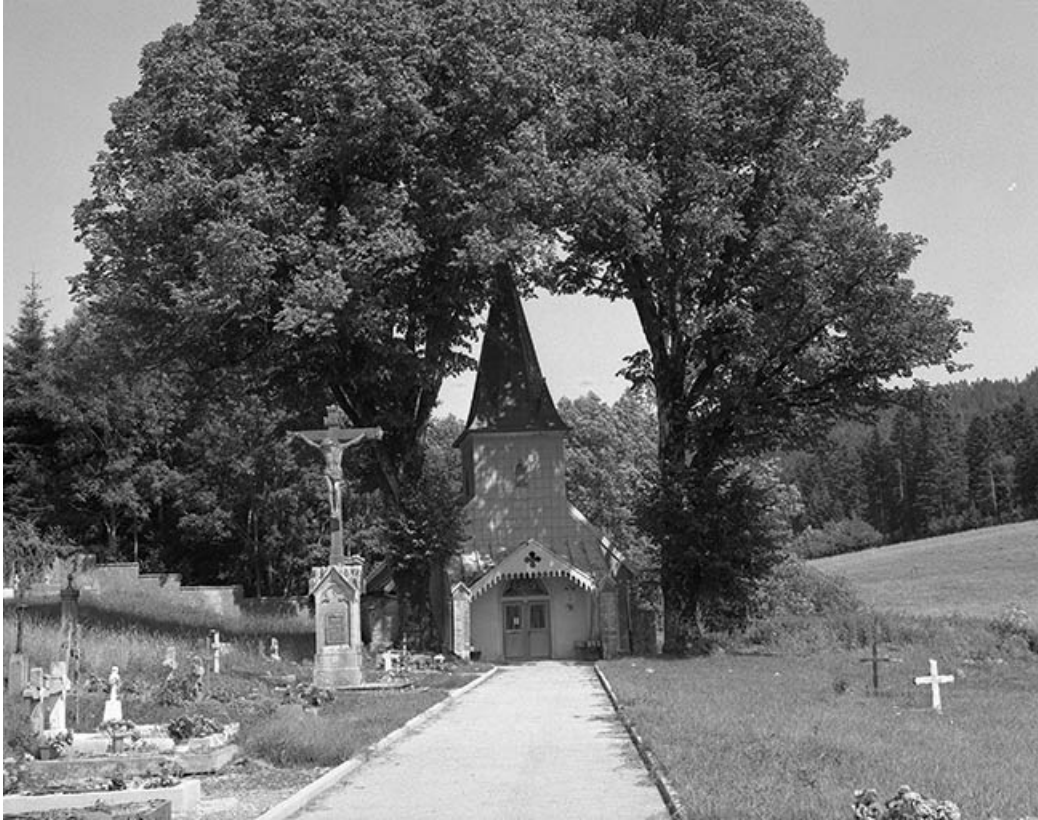
Façade antérieure et cimetière.
