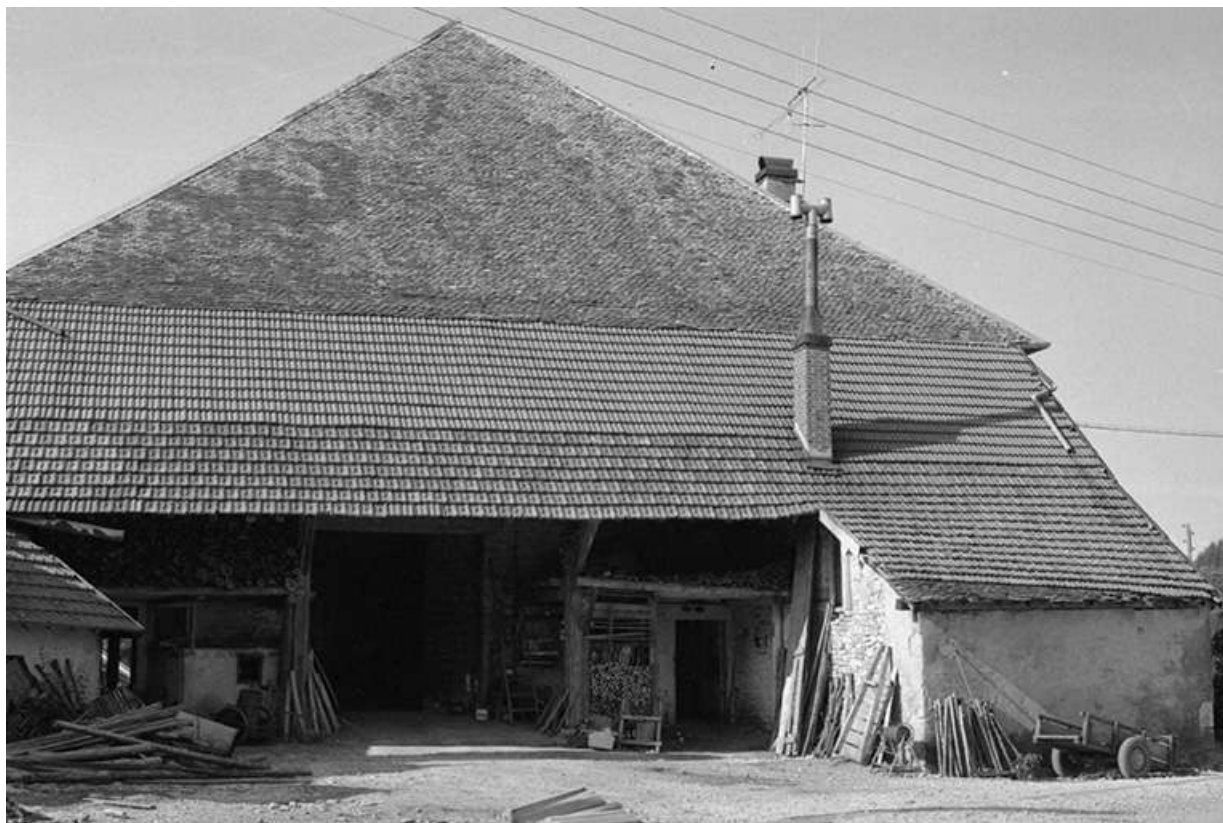
Façade latérale gauche.
