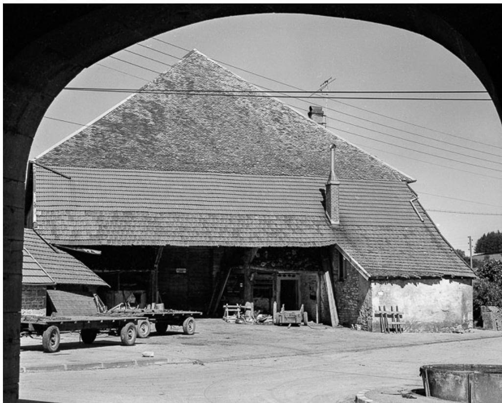
Façade latérale gauche.
