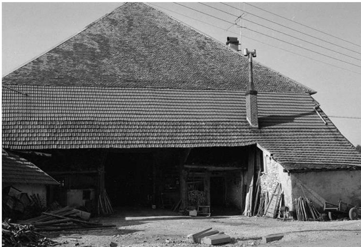
Façade latérale gauche.
