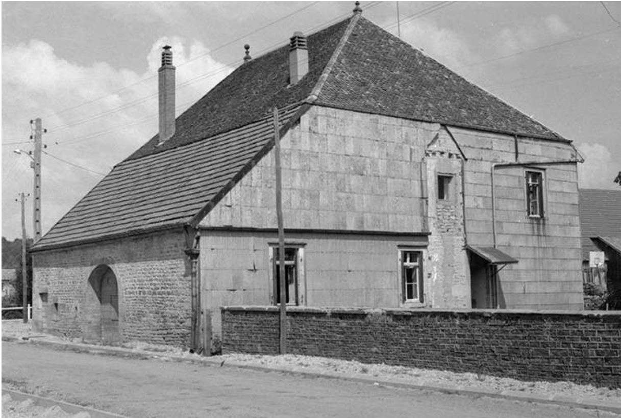
Façades postérieure et latérale droite.
