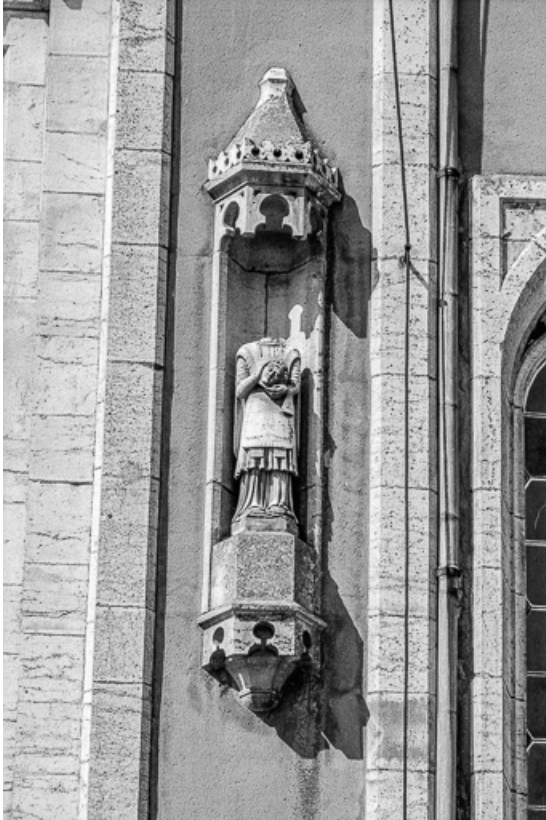
Détail de la tour-clocher : saint Ferréol.
