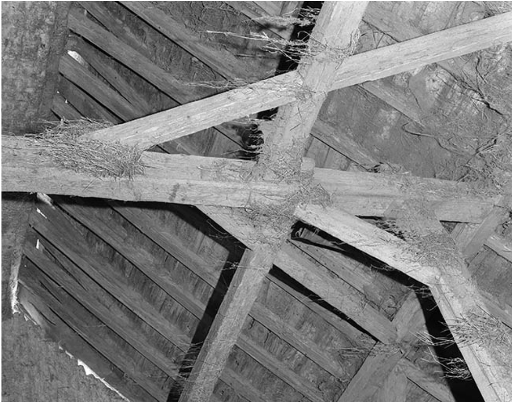
Poteau de charpente latéral d'une ferme.
