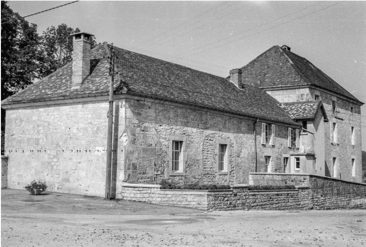
Façade sur la rue.
