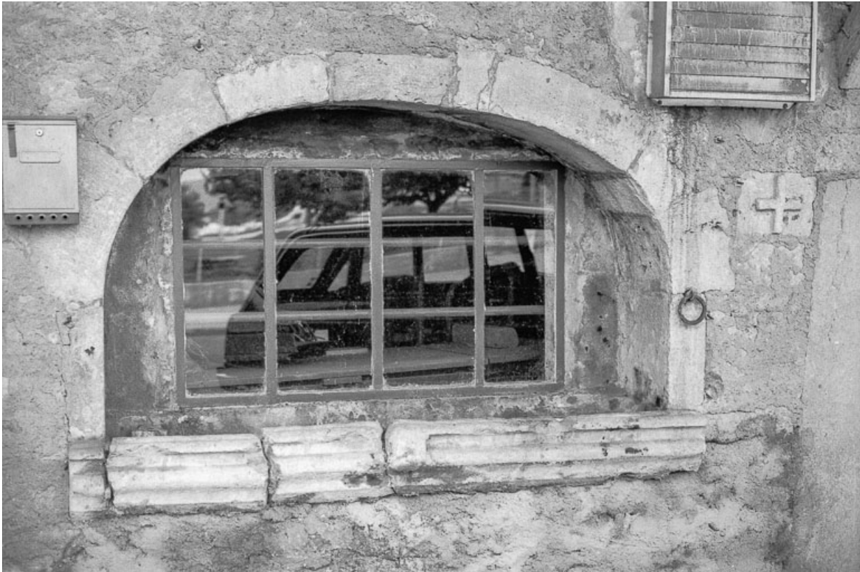
Fenêtre de l'écurie avec mangeoire.
