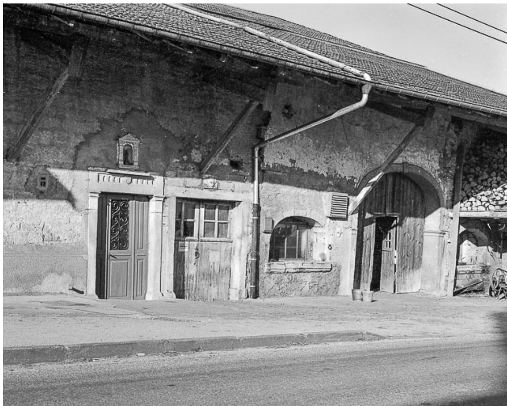
Détail de la façade sur rue.
