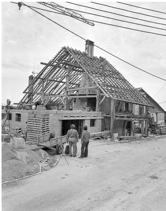
Ferme en cours de rénovation ve de la charpente.
