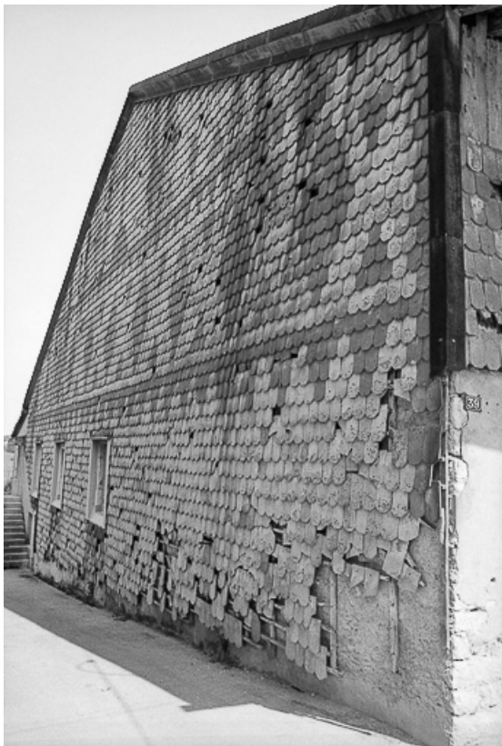
Ferme cadastrée 1962 E 106, 346-347 : façade avec tavillons. 25, Sombacour
