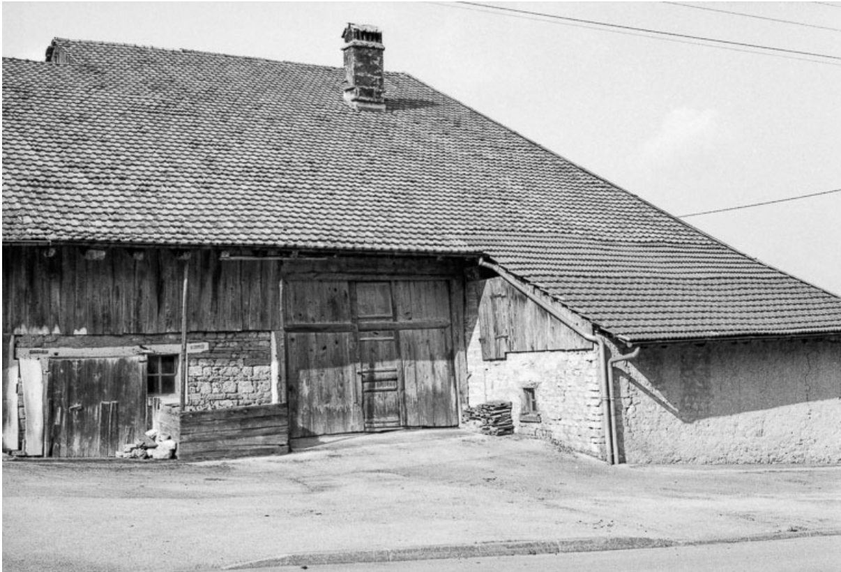
Ferme cadastrée 1962 E 182 : façade latérale droite (?). 25, Sombacour
