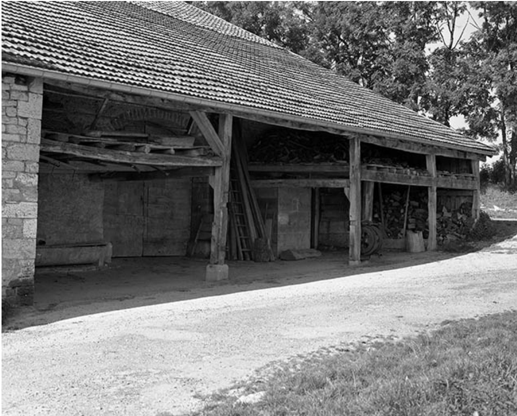
Façade latérale droite.
