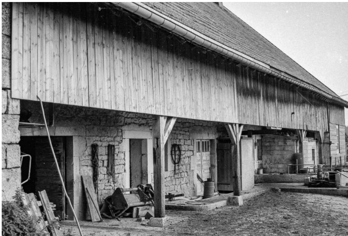
Mur gouttereau gauche.
