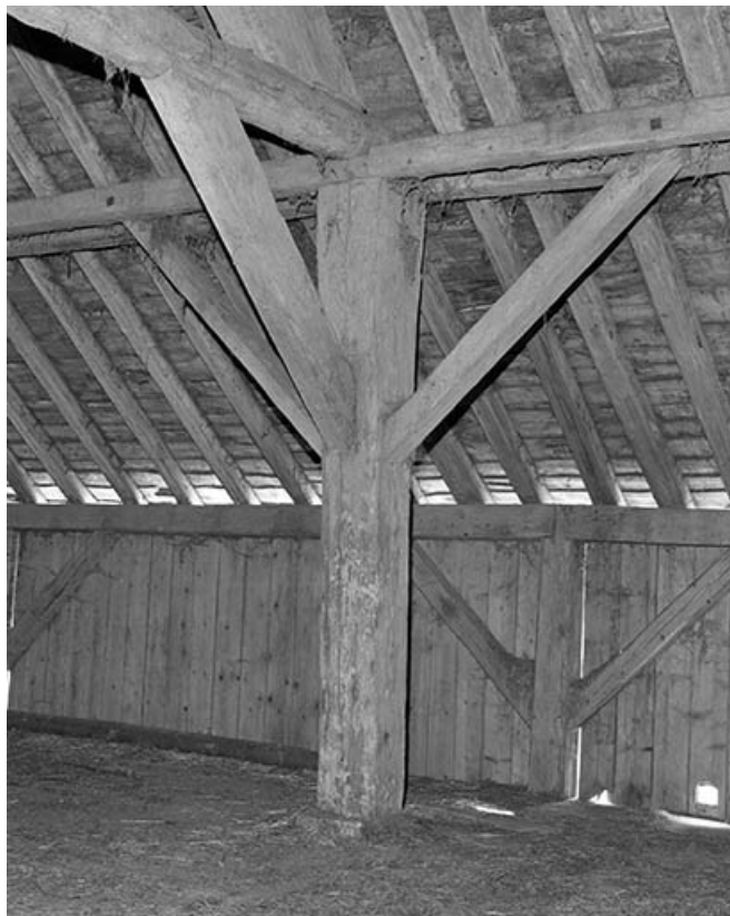
Charpente, partie inférieure au niveau d'une ferme.
