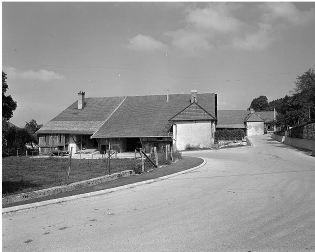
Vue d'ensemble des fermes.
