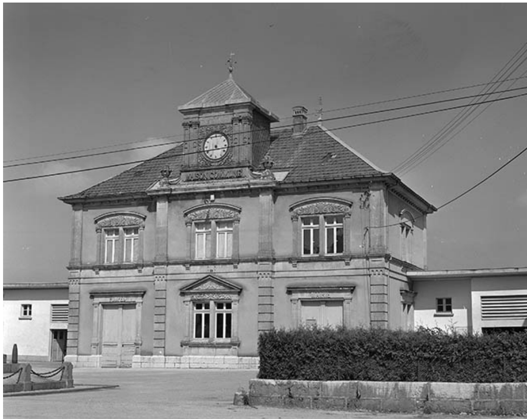
Façades antérieure et latérale droite.
