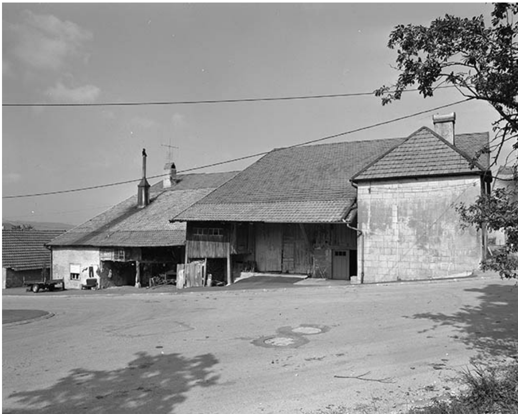
Gouttereau sur rue. 25, Goux-les-Usiers
