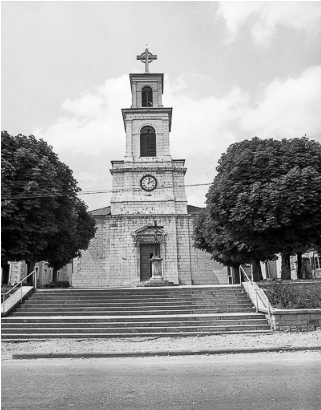
Extérieur : face antérieure.
