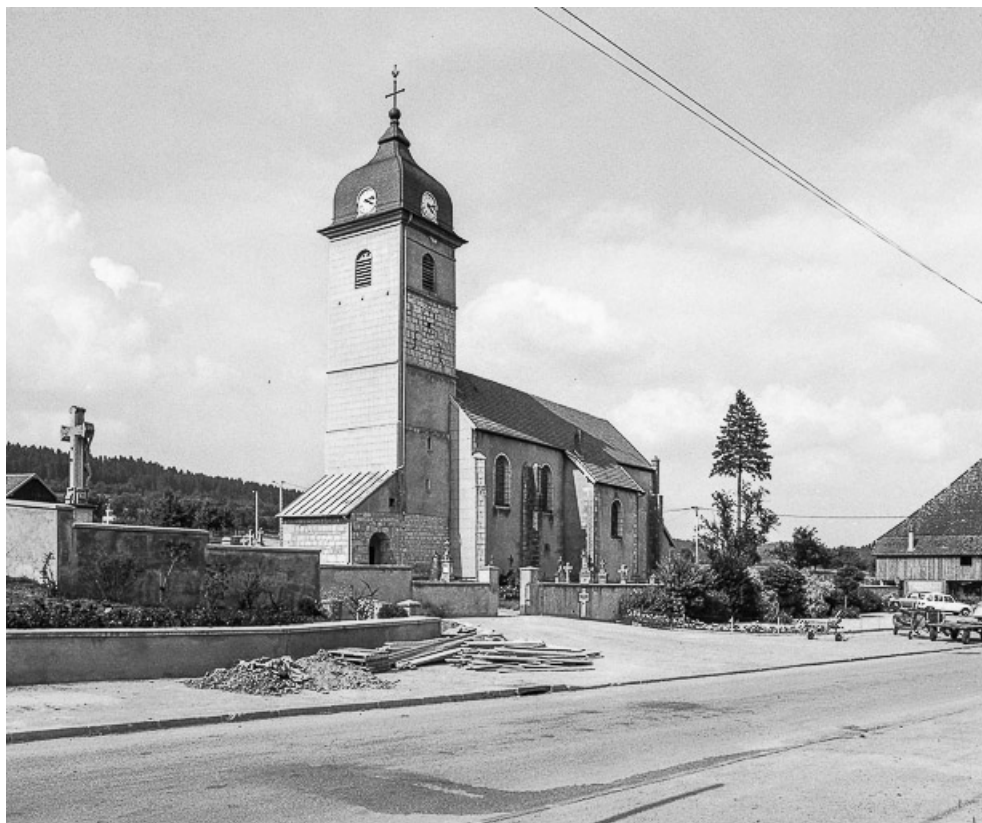
Extérieur : faces sud et ouest.
