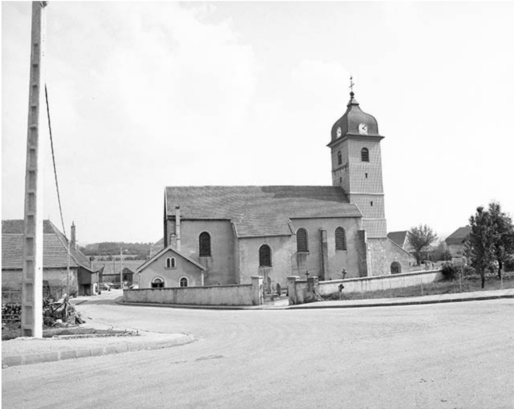
Extérieur : face latérale nord.
