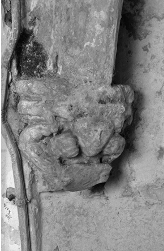
Culot du rez-de-chaussée de la tour-clocher.
