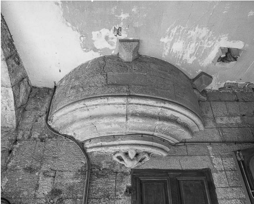
Base de l'escalier de la tour-clocher.
