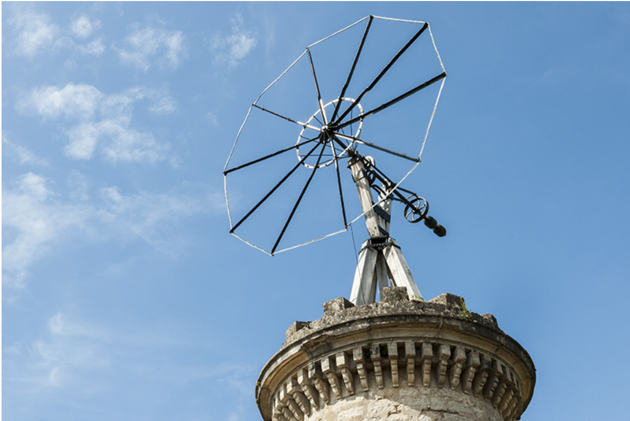
Structure supérieure : roue motrice ou hélice éolienne.
