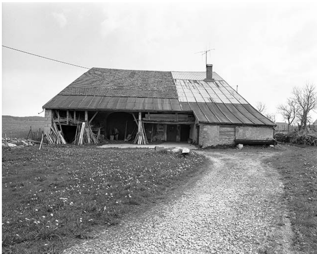
Extérieur : gouttereau antérieur.
