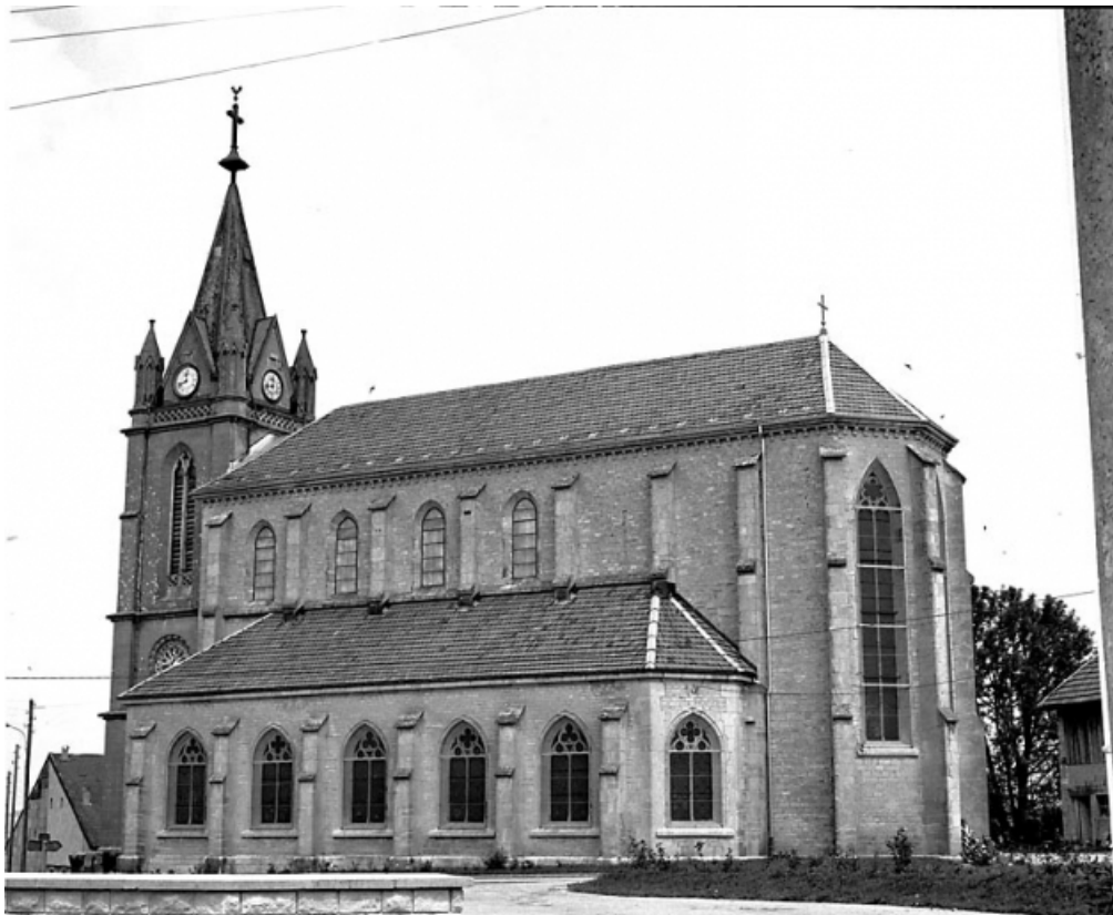
Façade latérale sud.
