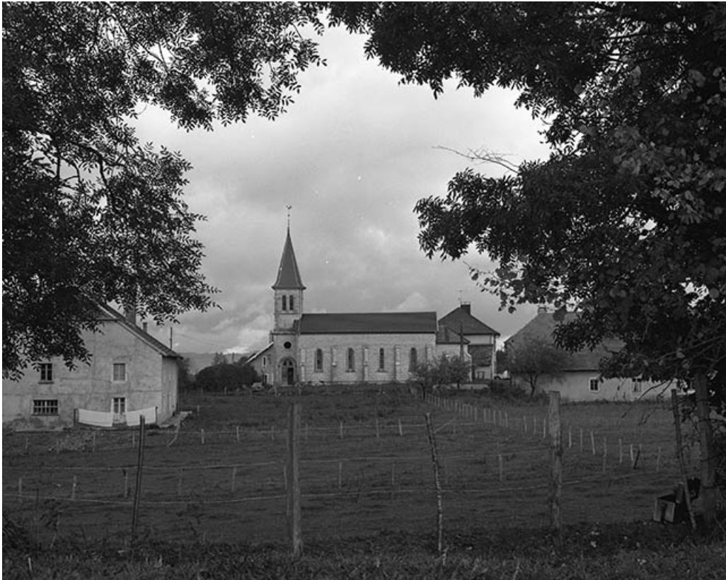
Façade latérale sud.
