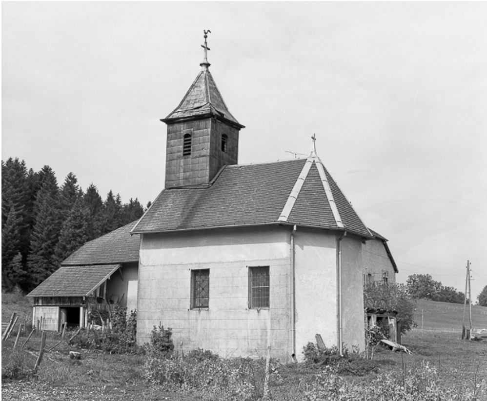
Vue extérieure : abside et face latérale droite.
