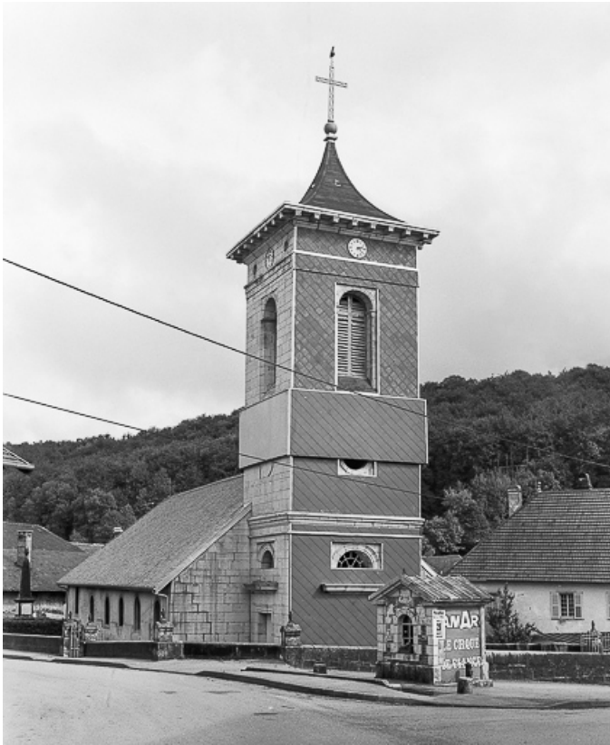
Extérieur : façade antérieure.
