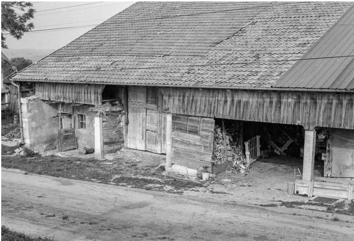
Façade latérale gauche sur rue : partie gauche.
