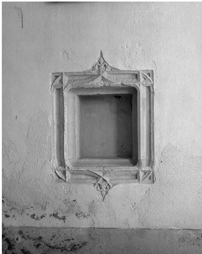
Extérieur : détail, niche.
