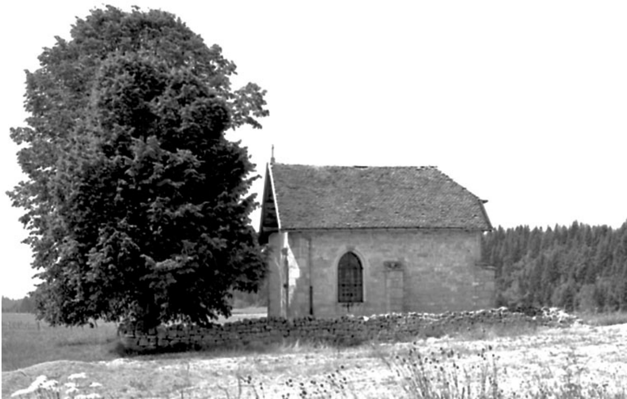
Façade latérale sud.
