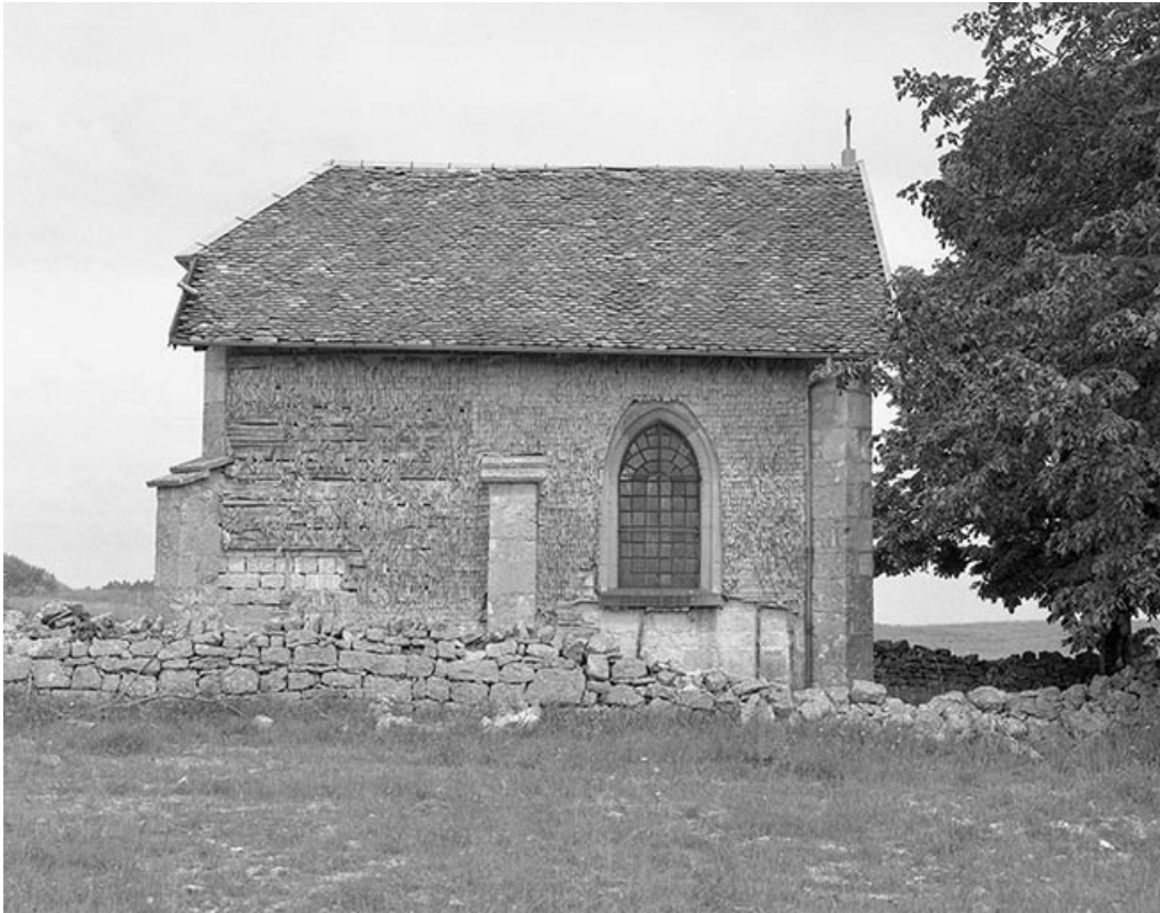
Façade latérale nord.
