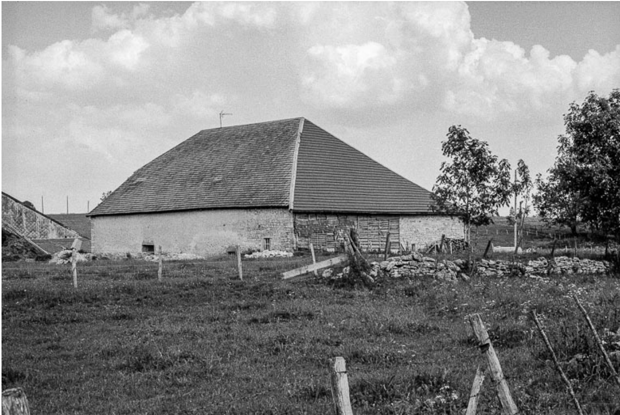
Ferme, cadastrée 1938 F 62 : façade postérieure. 25, Boujailles
