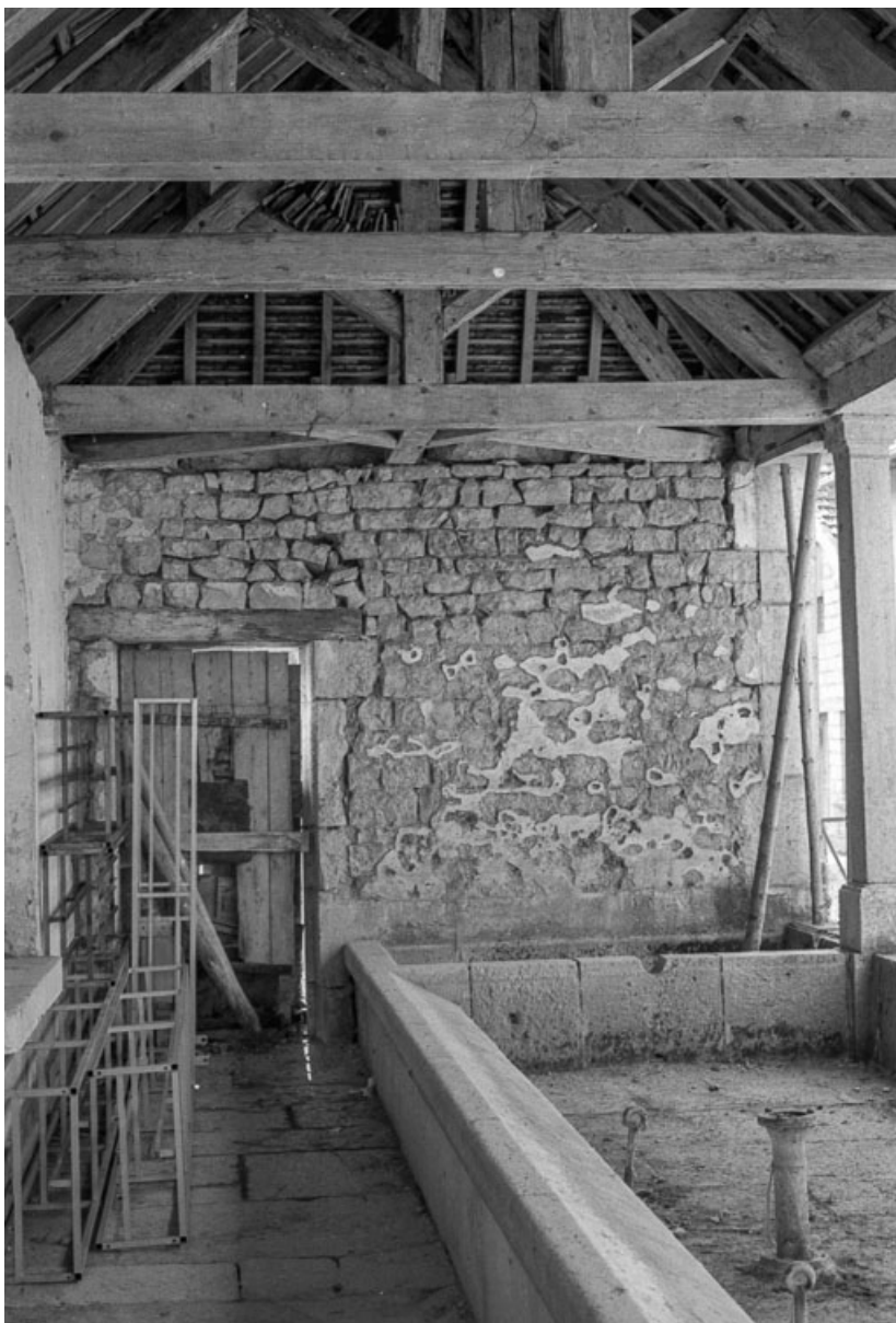
Intérieur : bassin et charpente.
