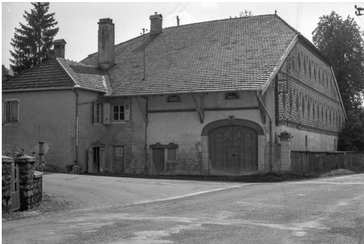
Façades postérieure et latérale droite.
