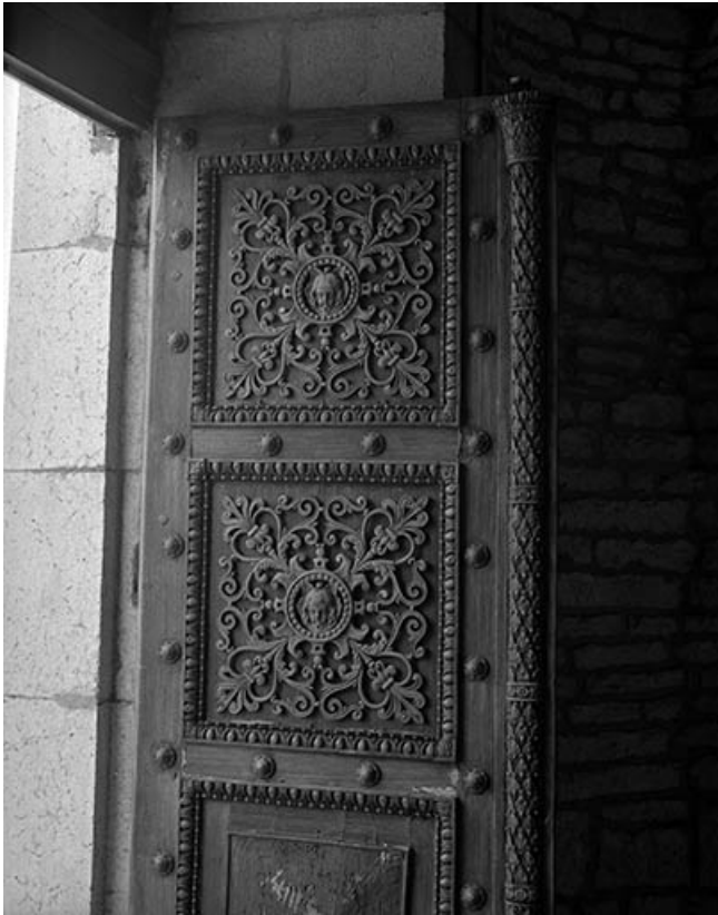
Baie : porte d'entrée.
