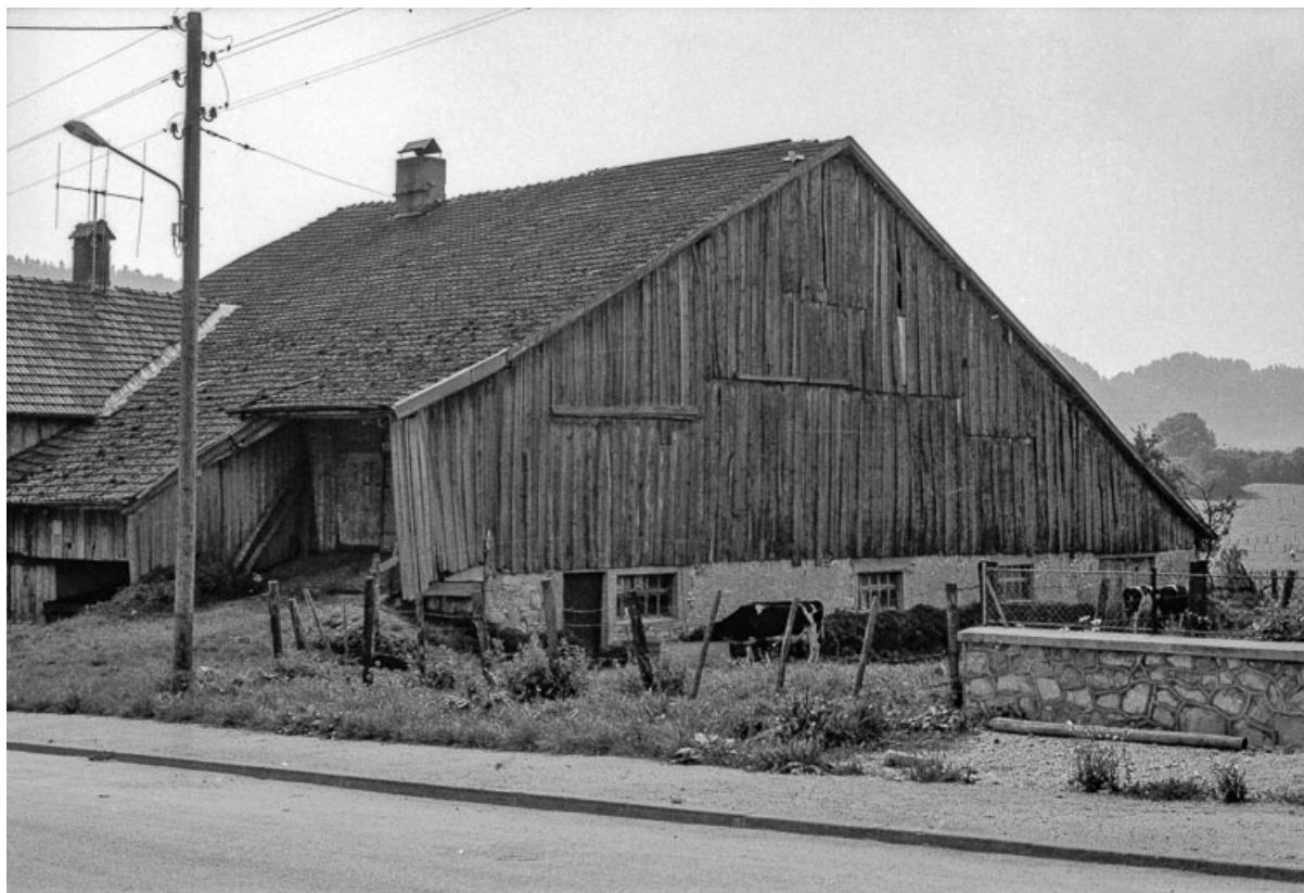
Ferme : façade latérale droite.
