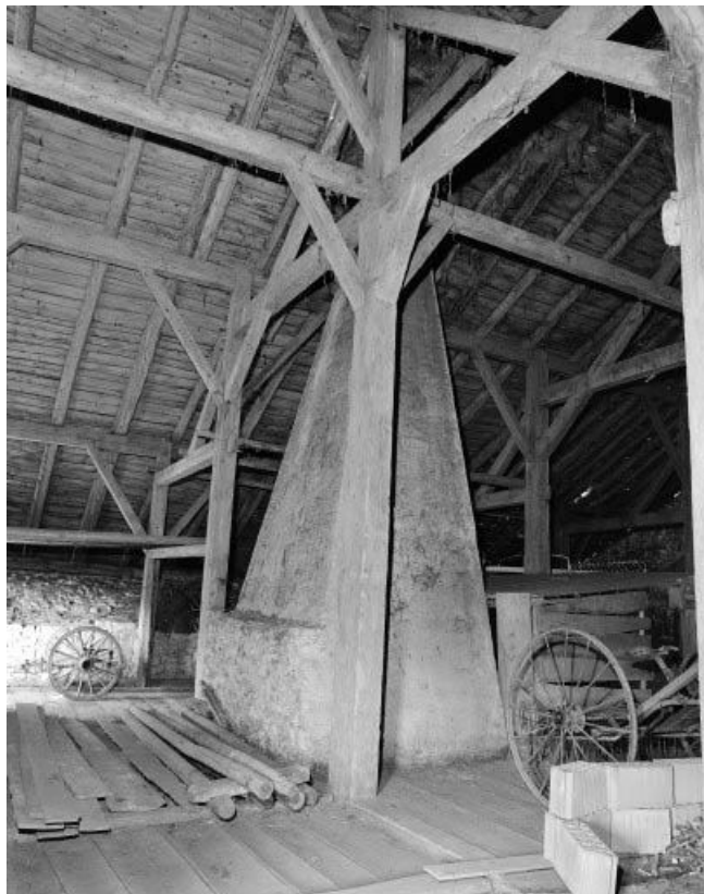
Charpente et conduit de cheminée.
