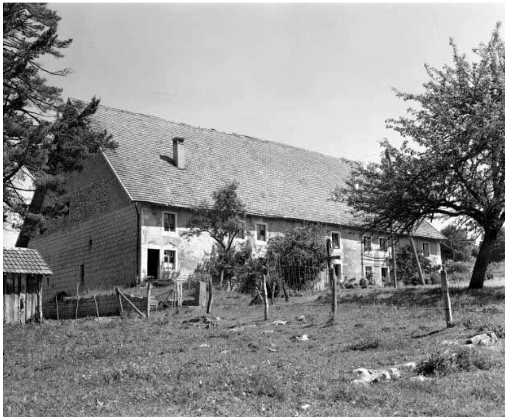
Façades antérieure et latérale gauche.
