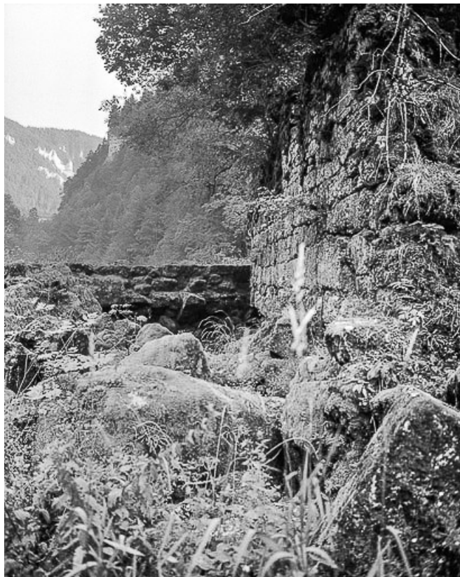
Entrée du canal.
