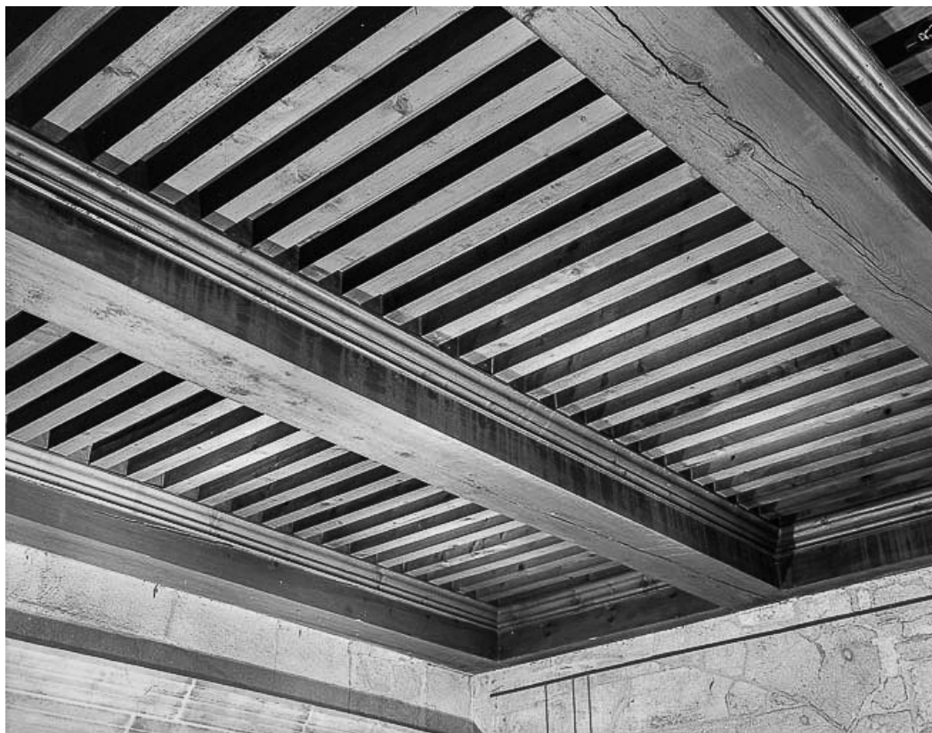
Vue du plafond.
