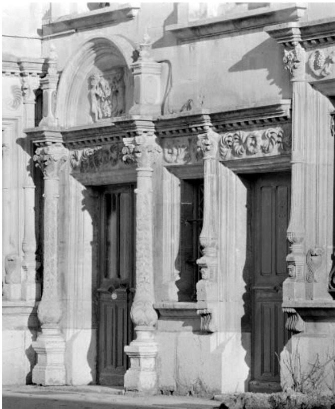
Détail : portail d'entrée.
