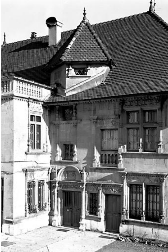
Façade sur cour.
