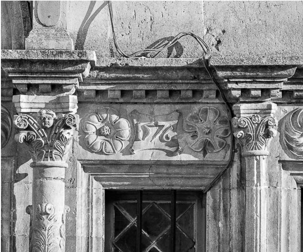
Linteau de fenêtre du rez-de-chaussée.
