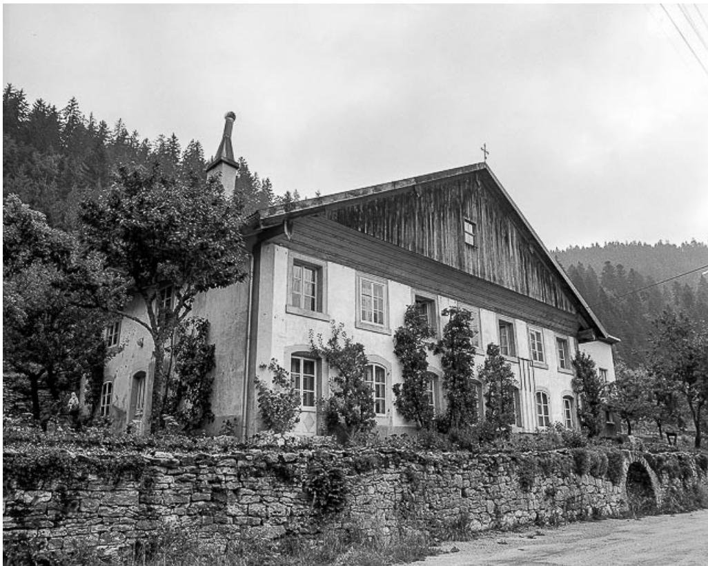
Montlebon, lieu-dit Derrière le Mont : vue d'ensemble.
