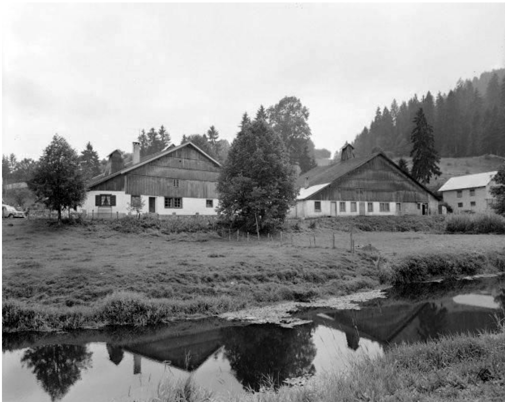
Fermes 1 et 2: façades antérieures.
