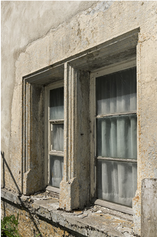
Façade est : fenêtres jumelées à encadrement mouluré.
