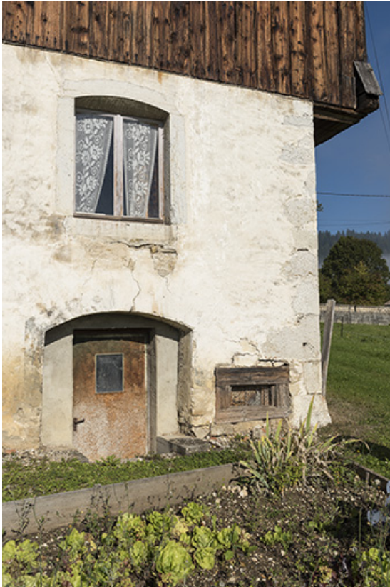
Façade est : accès au sous-sol (extension nord-est).
