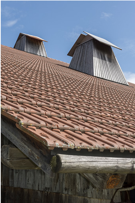
Pan de toiture sud, avec deux "tués".
