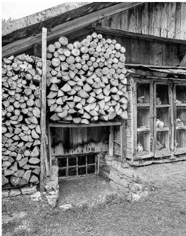
Détail : fenêtre de l'écurie.
