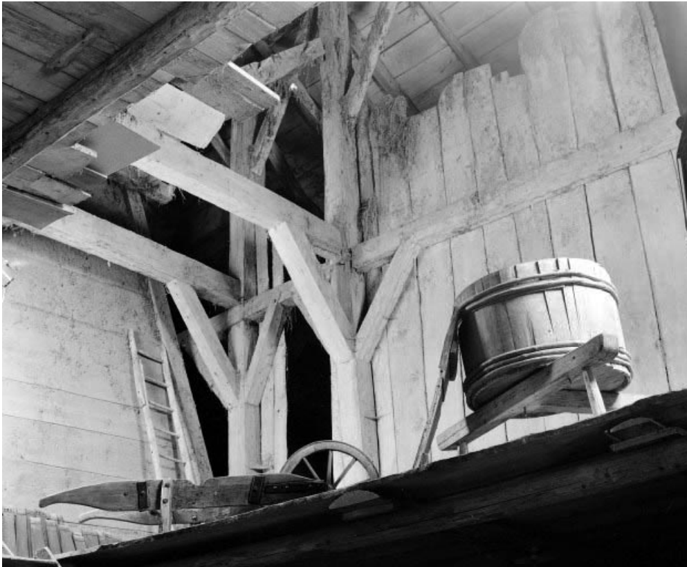
Intérieur : combles, fermes de charpente jumelées en arrière des "tués" au niveau de la faîtière. 25, Grand'Combe-Châtelet, lieudit : Bas de Grand-Combe
