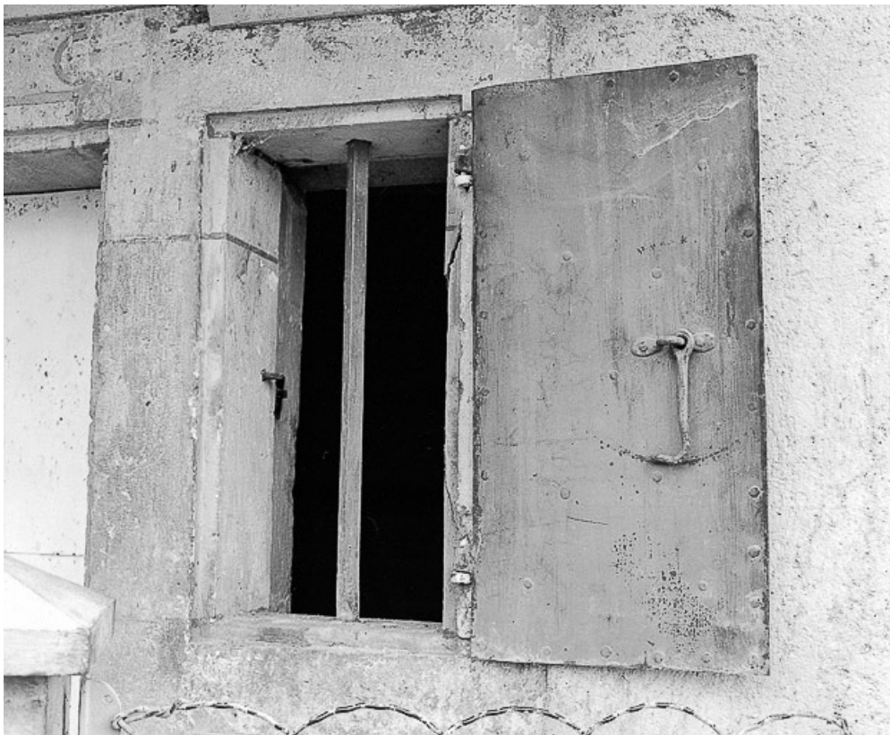
Façade antérieure : volet ouvert de la voûte.
