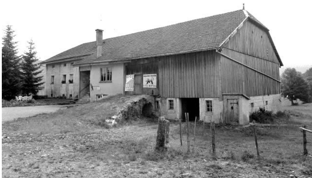
Façades postérieure et latérale gauche.
