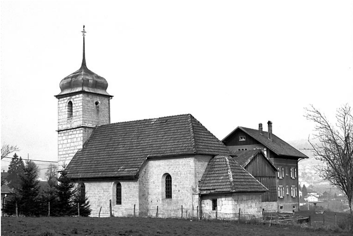
Face latérale droite vue depuis le sud-est.
