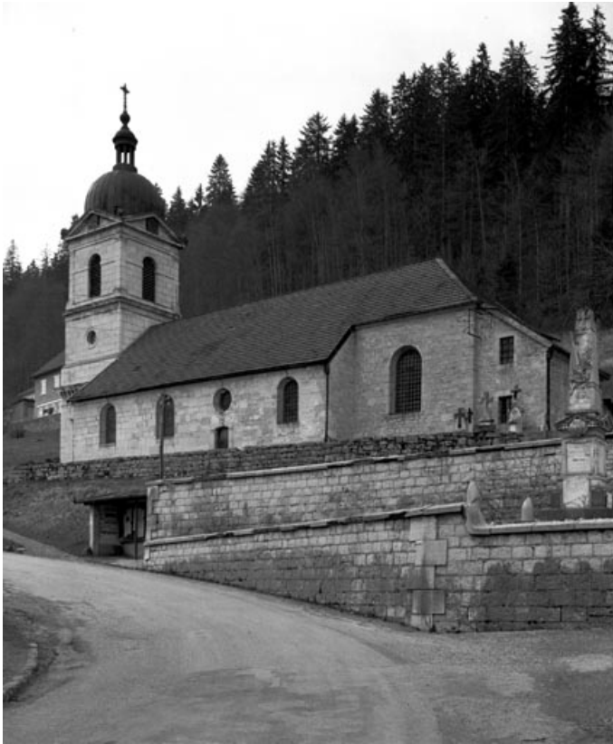
Façade latérale sud.
