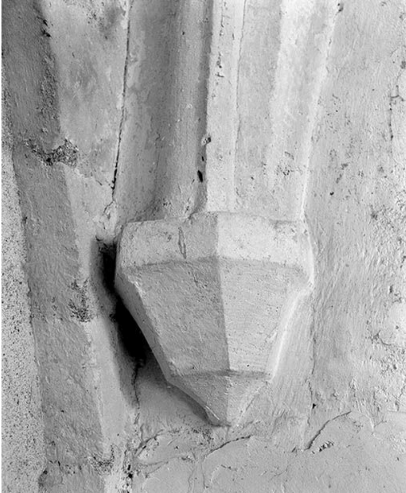
Clocher, niveau inférieur : culot postérieur gauche.
