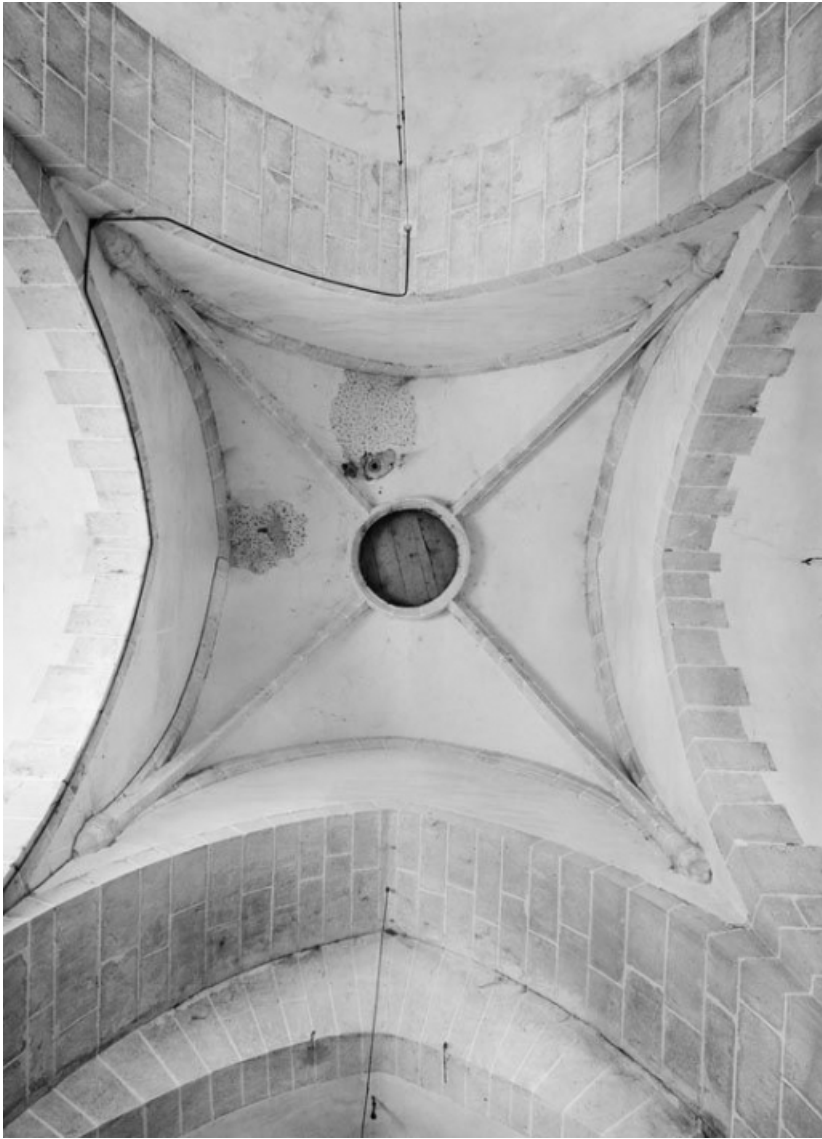
La voûte de la travée sous clocher.
