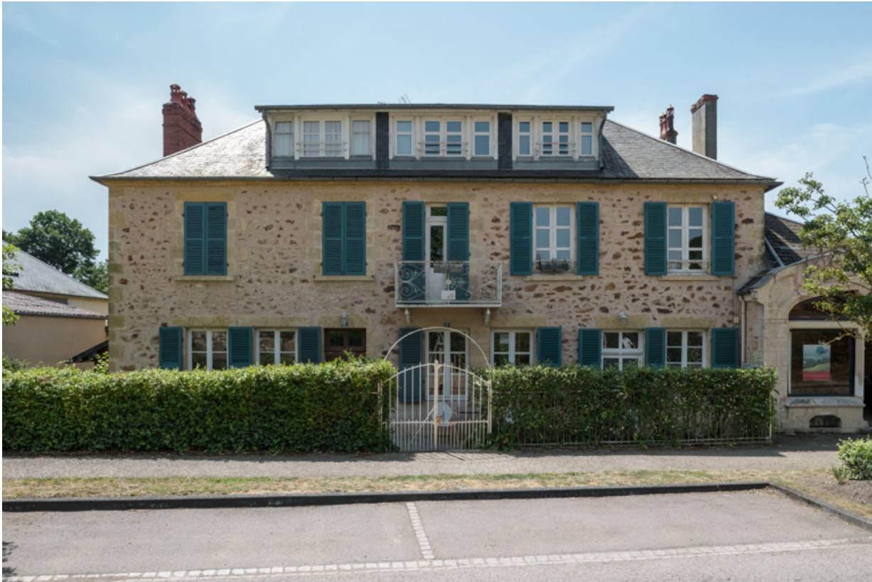
Façade actuelle sur l'avenue, vue de face.
