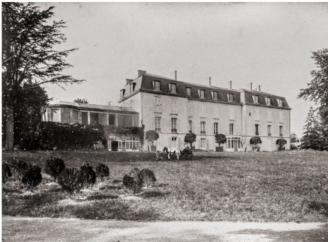
Façade sud-est du corps de logis.
