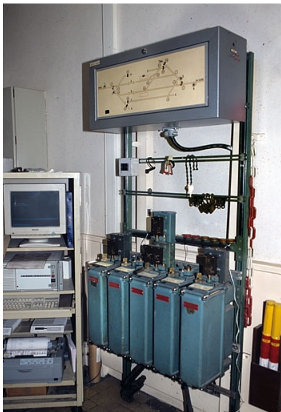
Vue d'ensemble, de trois quarts droite. Le tableau de contrôle optique surmonte les commutateurs. A gauche, ordinateur du système CAPI (cantonement assisté par informatique).
