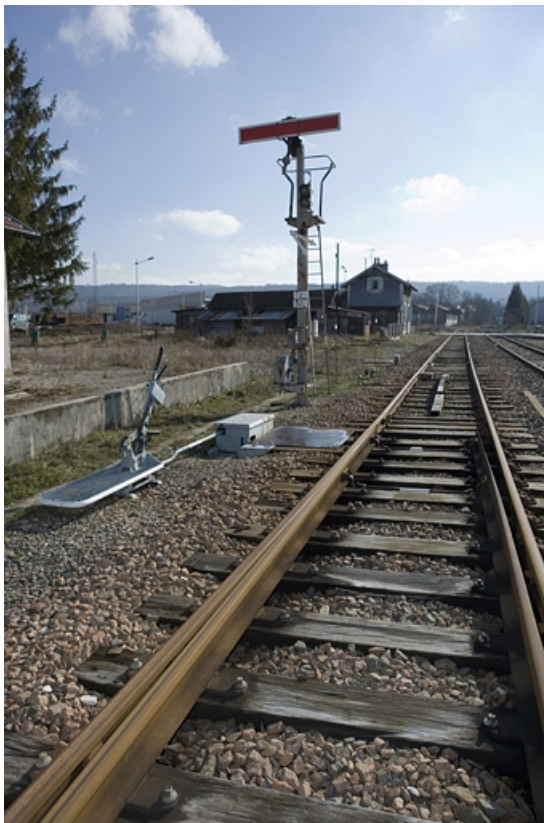
Vue d'ensemble, depuis le côté Andelot-en-Montagne.
